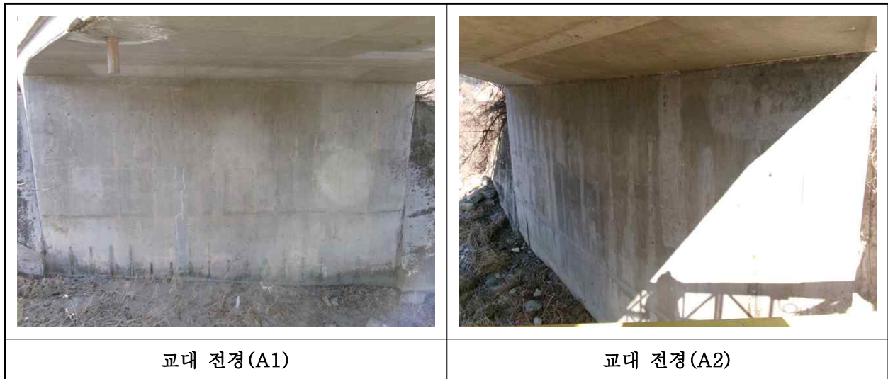
【사진 1.3.4】 교대 전경
