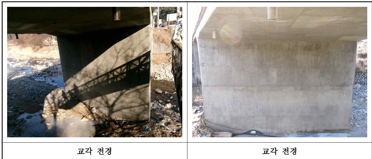
【사진 1.3.6】 교각 전경
