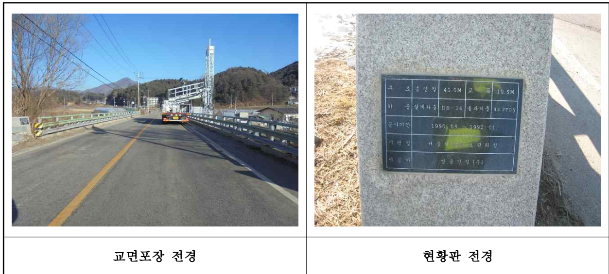
【사진 1.3.8】 교면포장 전경
