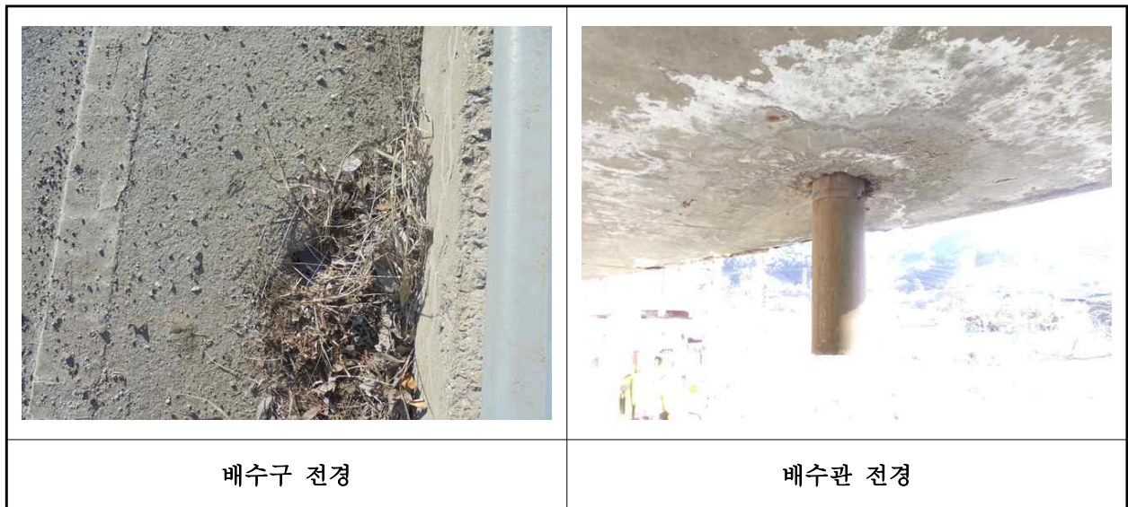
【사진 1.3.10】 배수시설 전경
